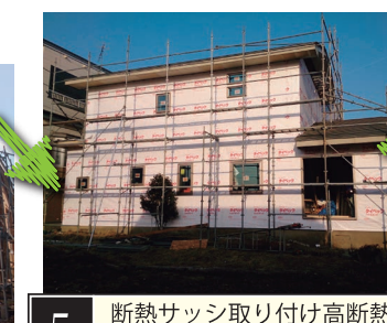
5 断熱サッシ取り付け高断熱LOW-Eガラス仕様
