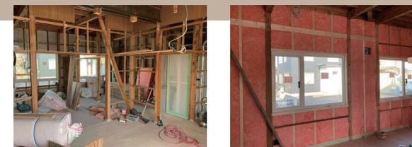
築40年のアパート、2LDKの内部を全て解体して断熱リフォームをしました。一般住宅でも一階部分だけでも断熱リフォームは可能ですのでお気軽にご相談下さい。
